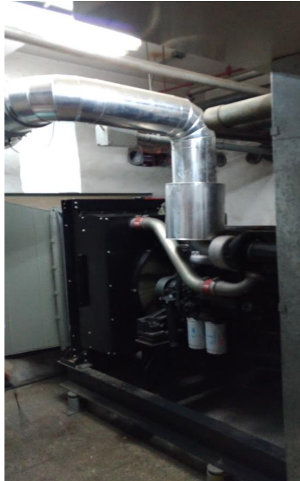
緊急發電機(300KW)
