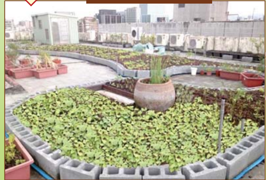
綠屋頂改善後
