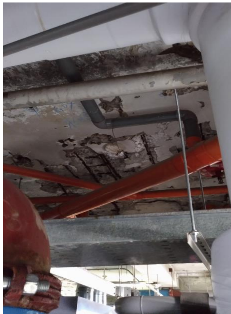
地下室機房頂板現況
