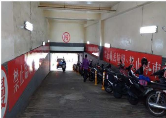
7 市場內二樓車道及卸貨空間
