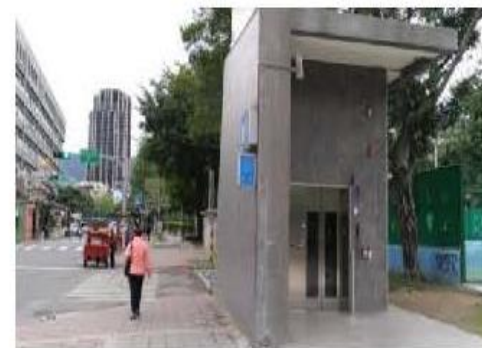
4 大豐公園地下停車電梯出入口
