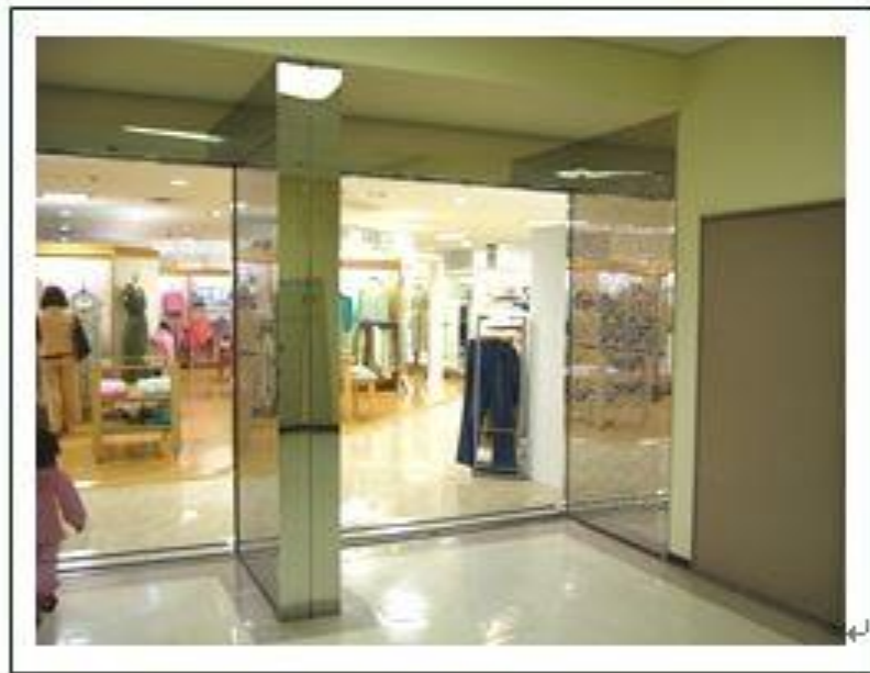
▲ 常時開放式防火門↵
