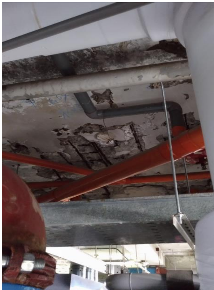
地下室機房頂板現況
