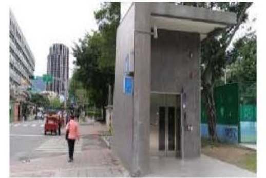
4 大豐公園地下停車電梯出入口
