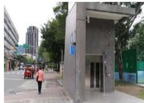
4 大豐公園地下停車電梯出入口
