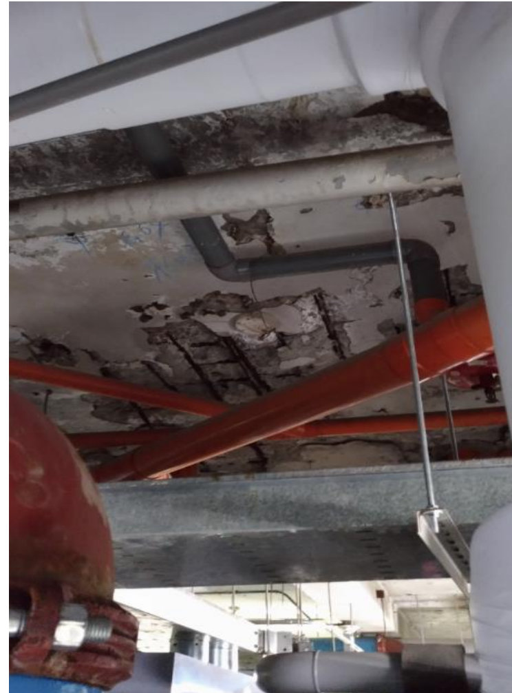
地下室機房頂板現況
