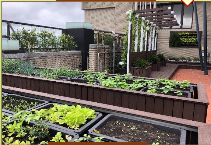
綠屋頂改善後
