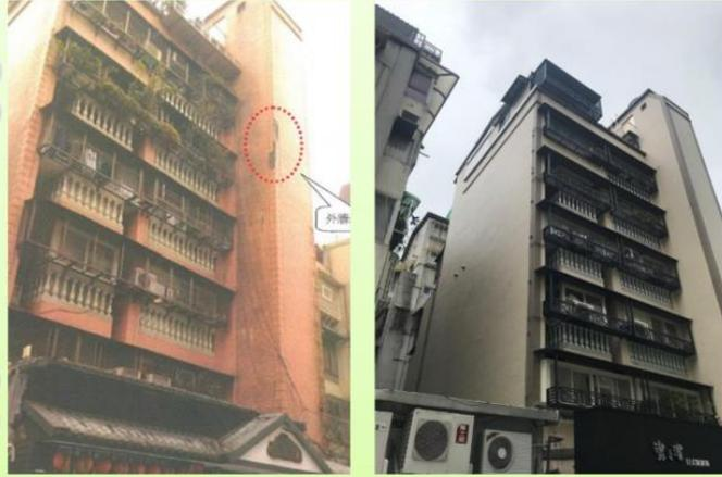
修復工法或防護方式：以整棟拉皮重貼磁磚施作
