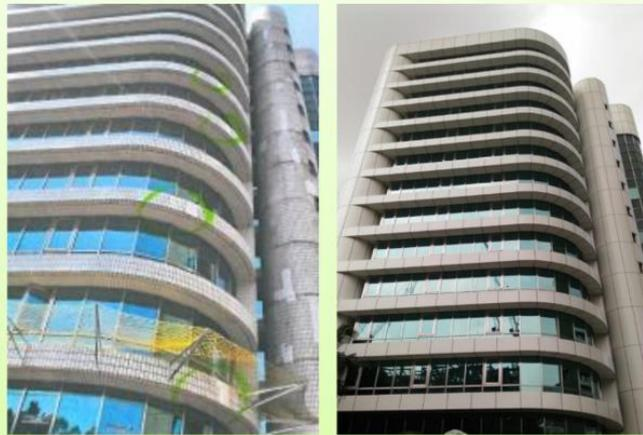
修復工法或防護方式：拆除防護網、整棟拉皮
