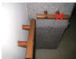
扶手應採L型方式支撐，以免影響扶著扶手上前進之順暢性
