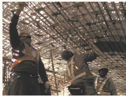
曲牆金屬網模板現場裝設
