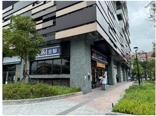
圖9 稻香合署大樓一樓照片
