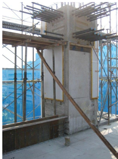
(2)實際梁柱接頭施工圖
