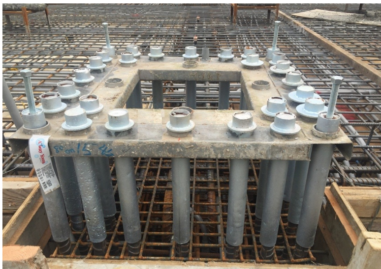
圖 R9.4 接合用鋼筋之定位板照片
