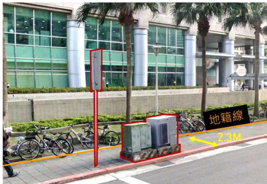
街220巷 交通號誌、台電電箱
