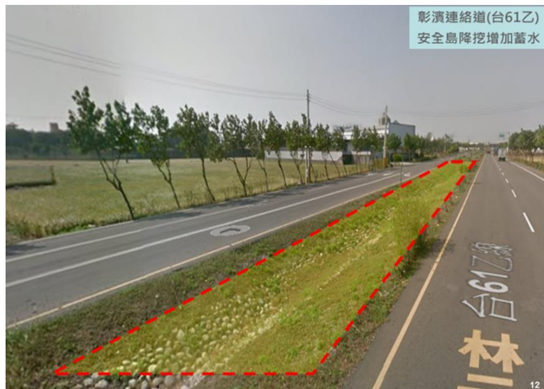
(a) 彰濱連絡道台 61 乙安全島降挖增加蓄水空間
