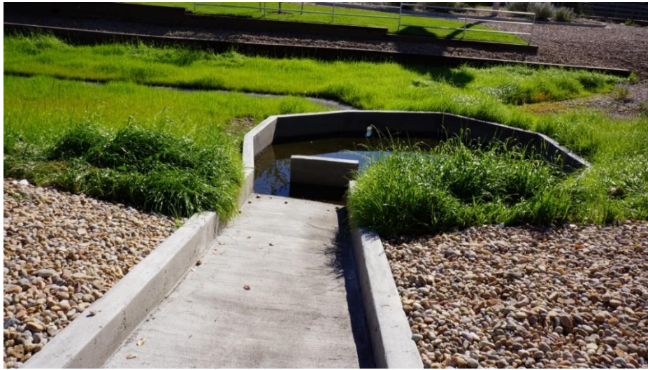
圖II-5-7 入流工之消能與沉砂前池示意照片
