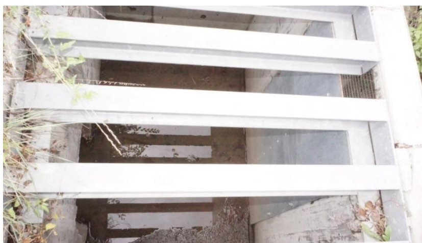
圖II-5-11 豎井式出流工與聯外排水路箱涵連結情形
