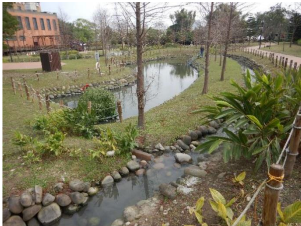
圖II-5-14 離槽式滯洪池-新北哈客樂園景觀營造工程滯洪池
