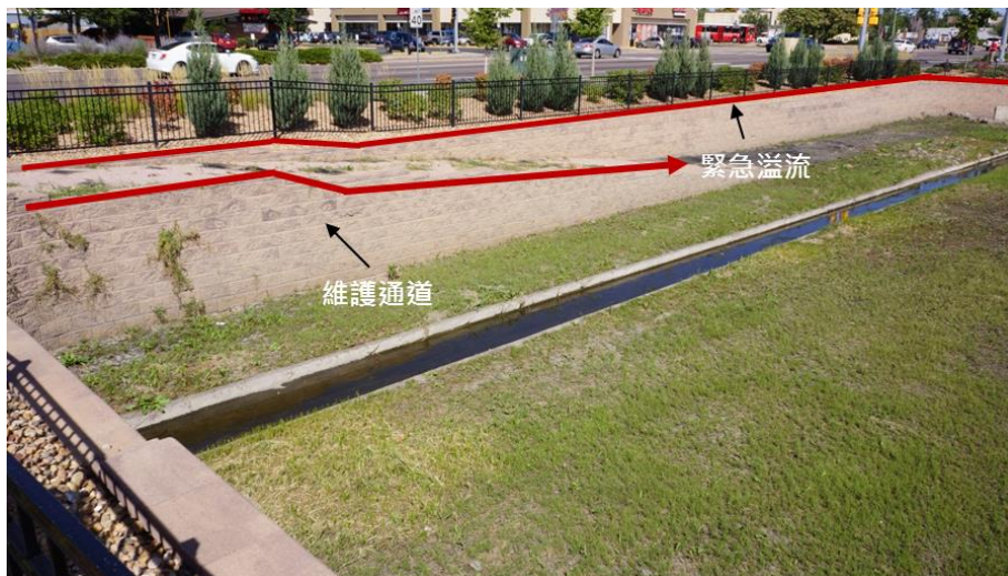
圖II-5-6 滯洪設施為維護通道及降低堤岸高程為緊急溢流示意照片
