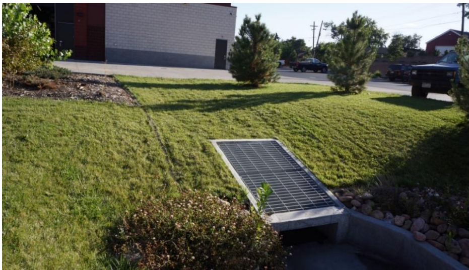
圖II-5-8 出流工及攔污柵設施示意照片
