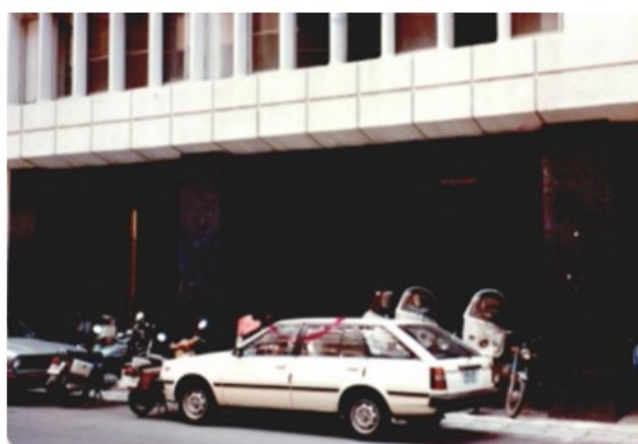
▲ 72使字第[redacted]號使用執照 / 路緣高差18公分並劃設停車位 / 竣工當時路緣順平
