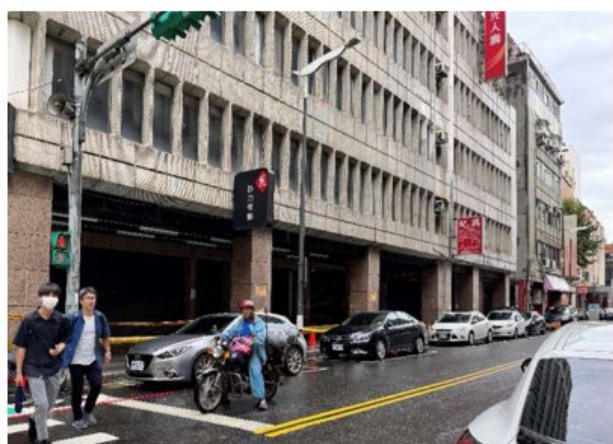
▲ 72使字第[redacted]號使用執照 / 路緣高差18公分並劃設停車位 / 竣工當時路緣順平
