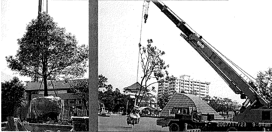
先估計樹木整體吊搬總重量以選擇安全有效機具
