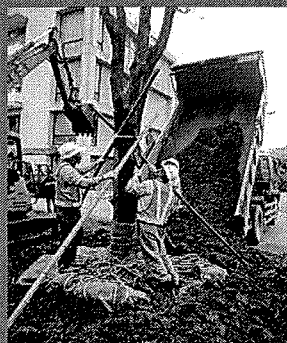
種植後填放砂質壤土，於根球四周均勻地填以表土及客土並壓實
