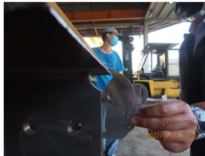
腹板與開槽進出面檢查
