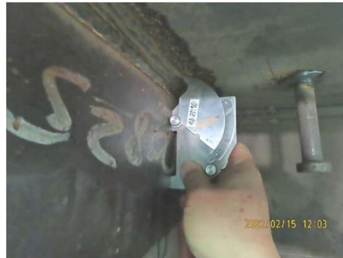
鋼柱內側銲道尺寸量測
