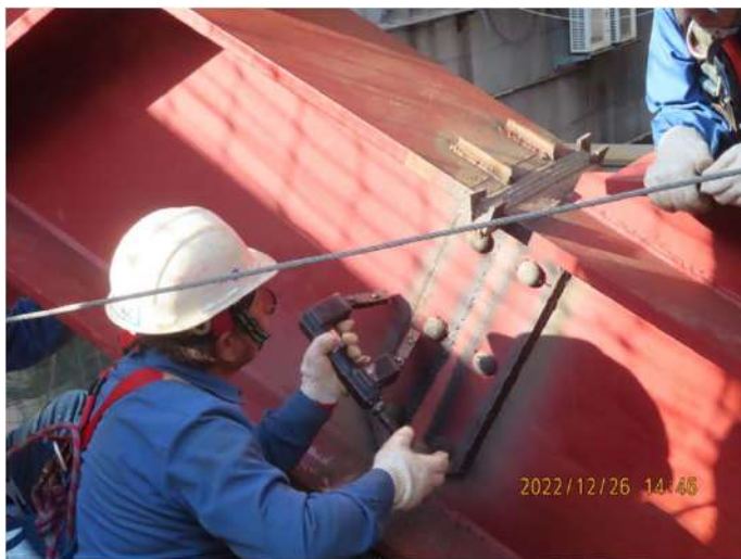
鋼構廠非破壞 M T 自檢
