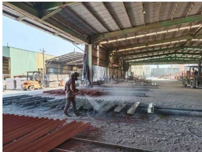
鋼構塗裝進行中
