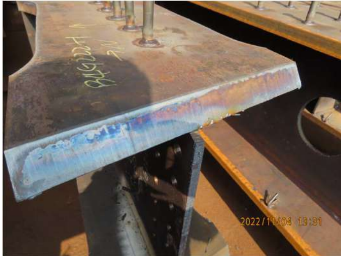
梁翼板切割開槽完成
