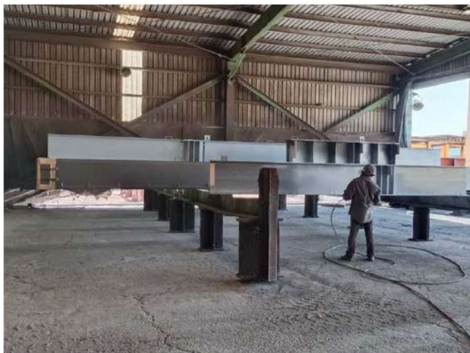
鋼構塗裝進行中
