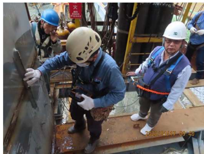
第三者梁柱接頭 U T 抽檢
