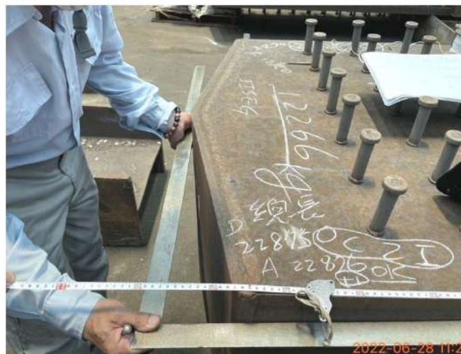
鋼柱尺寸量測
