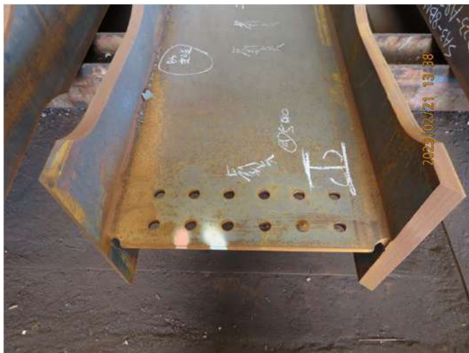
鋼梁開槽及鑽孔完成
