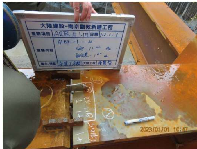
梁柱接頭板位差查驗
