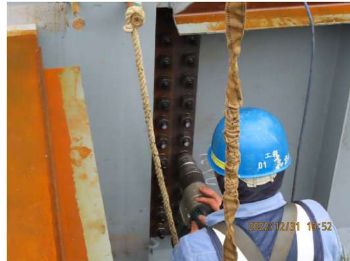
斷尾型螺栓鎖斷
