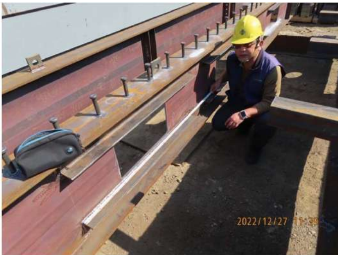
鋼梁開孔補強角鋼查驗
