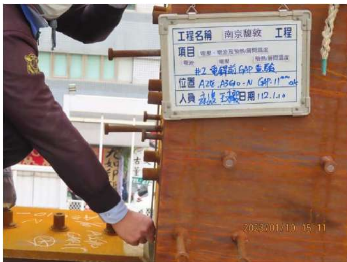
鋼梁根部間隙查驗
