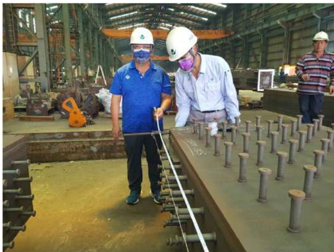
鋼柱長度檢查
