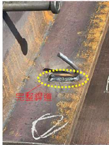
圖 19 安全網掛勾以完整焊道銲接於非塑性鉸區翼板之情況
