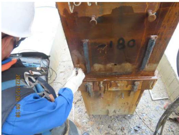
鋼構廠非破壞 U T 自檢
