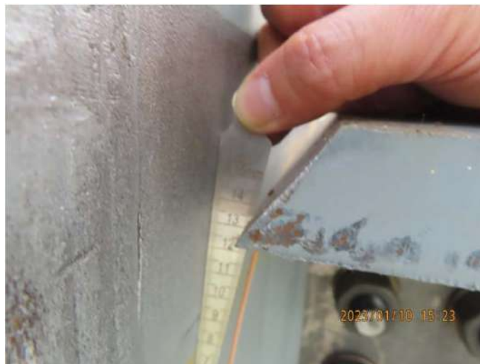
電焊前—根部間隙查驗
