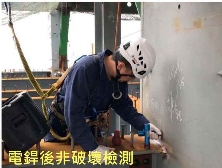
電銲後非破壞檢測
