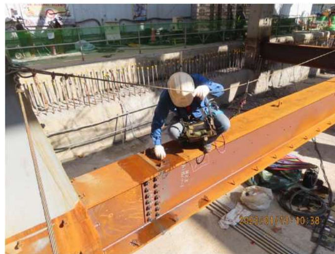
鋼構廠非破壞 U T 自檢
