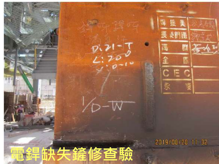
電銲後非破壞檢測
