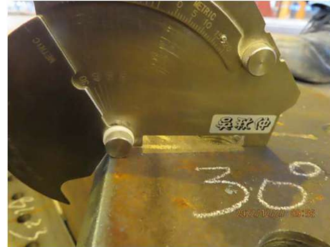
開槽角度量測
