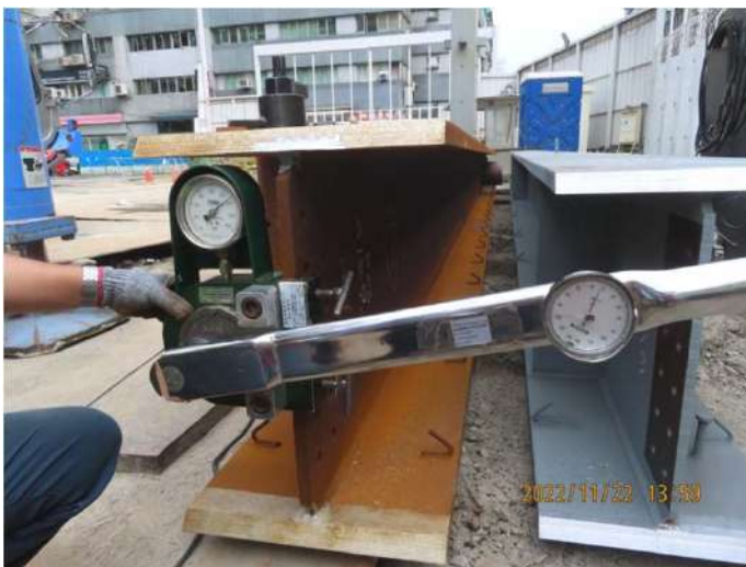
螺栓現場軸扭力試驗
