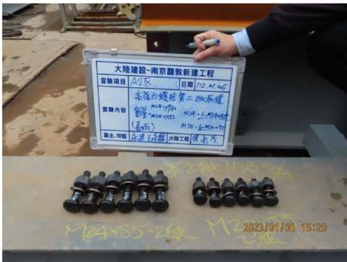
高強度螺栓進場及取樣
