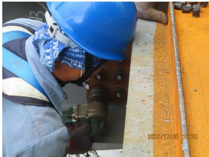
斷尾型螺栓鎖斷
