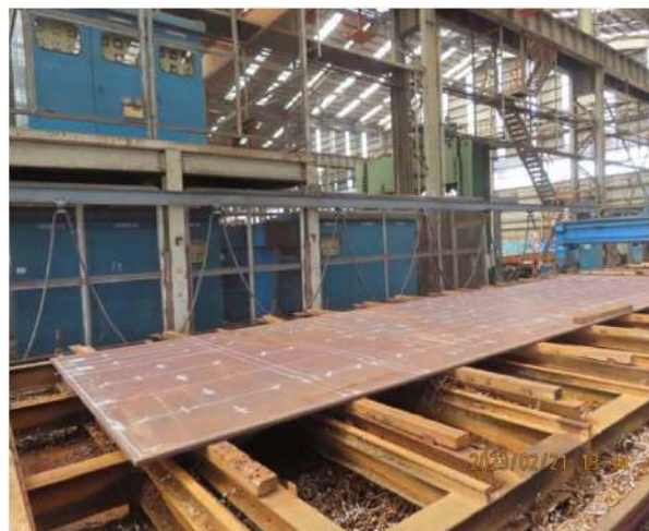
鋼板放樣完成
