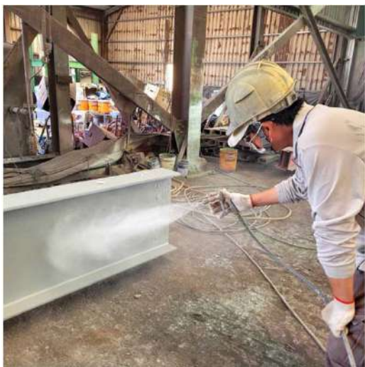
鋼構塗裝進行中
