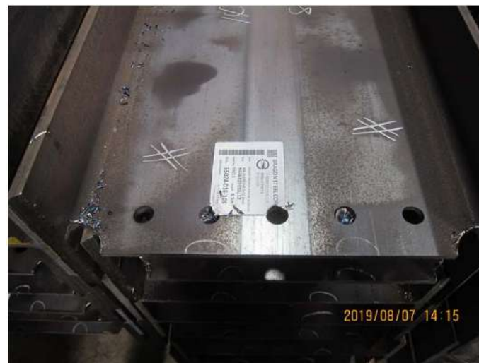
螺栓孔鑽孔完成
