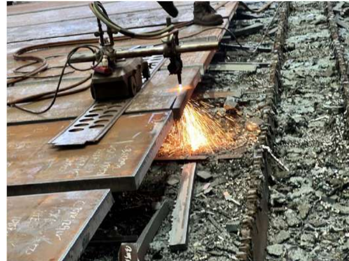
鋼板火焰切割
