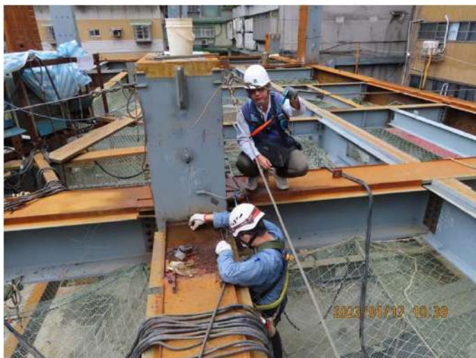
第三者梁柱接頭 U T 抽檢
