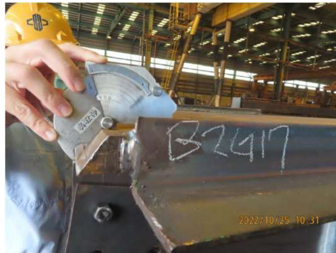
開槽角度量測
