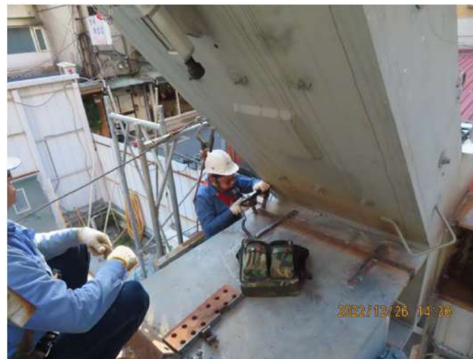
鋼構廠非破壞 M T 自檢
