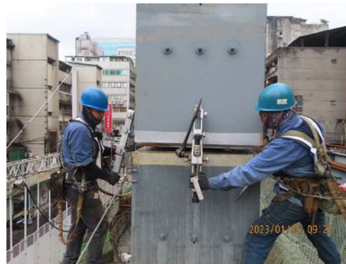
鋼柱安裝精度校正
