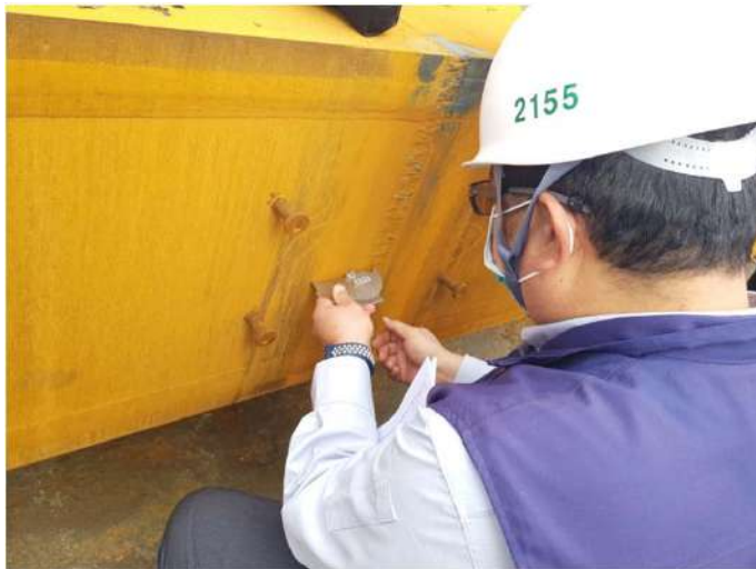
鋼柱銲道尺寸量測
