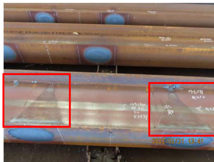
熱整形加強預拱完成
