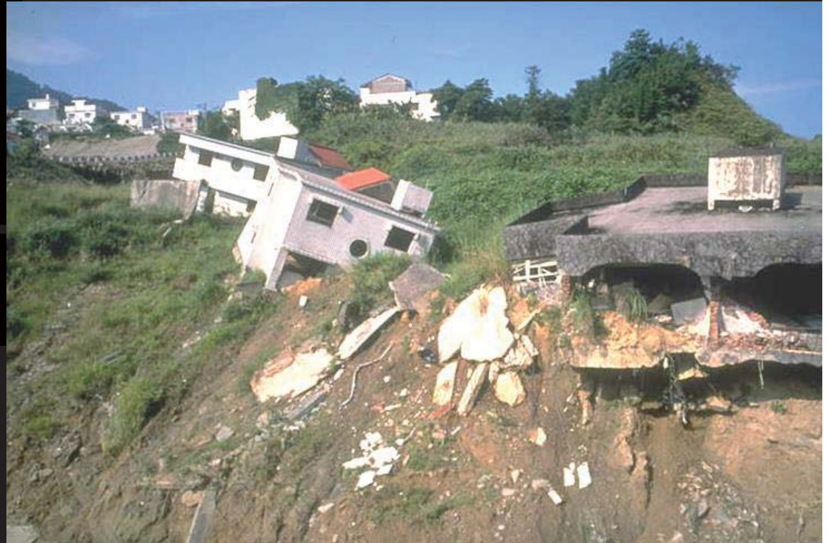
台北縣三峽白雞山莊因地層發生圓弧型滑動，造成房舍東倒西歪
