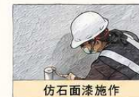
仿石面漆施作
