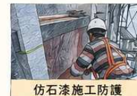
仿石漆施工防護
