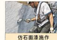
仿石面漆施作
