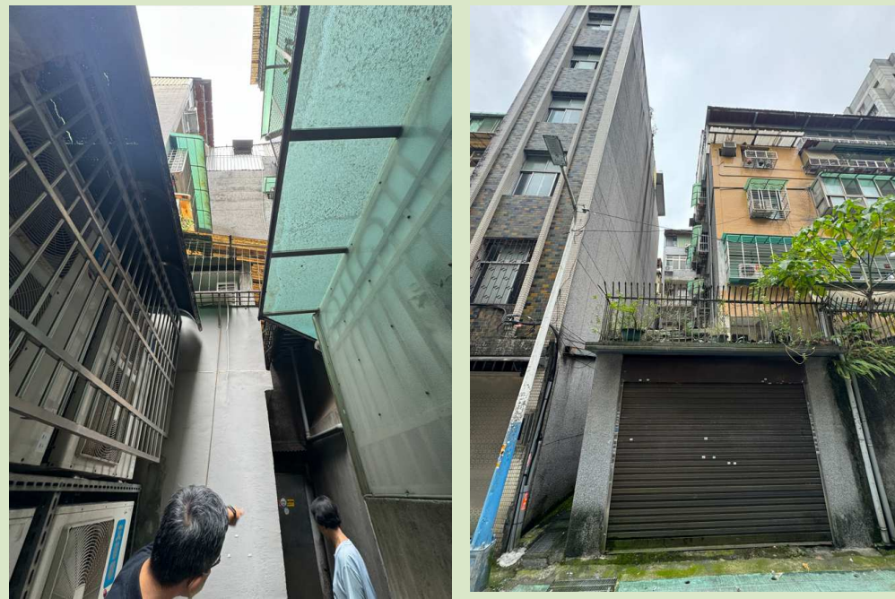
施工路徑不足
