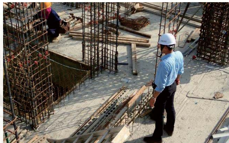
建築安全履歷協會 – 牆鋼筋施工察證
