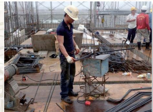
傳統鋼筋彎折
