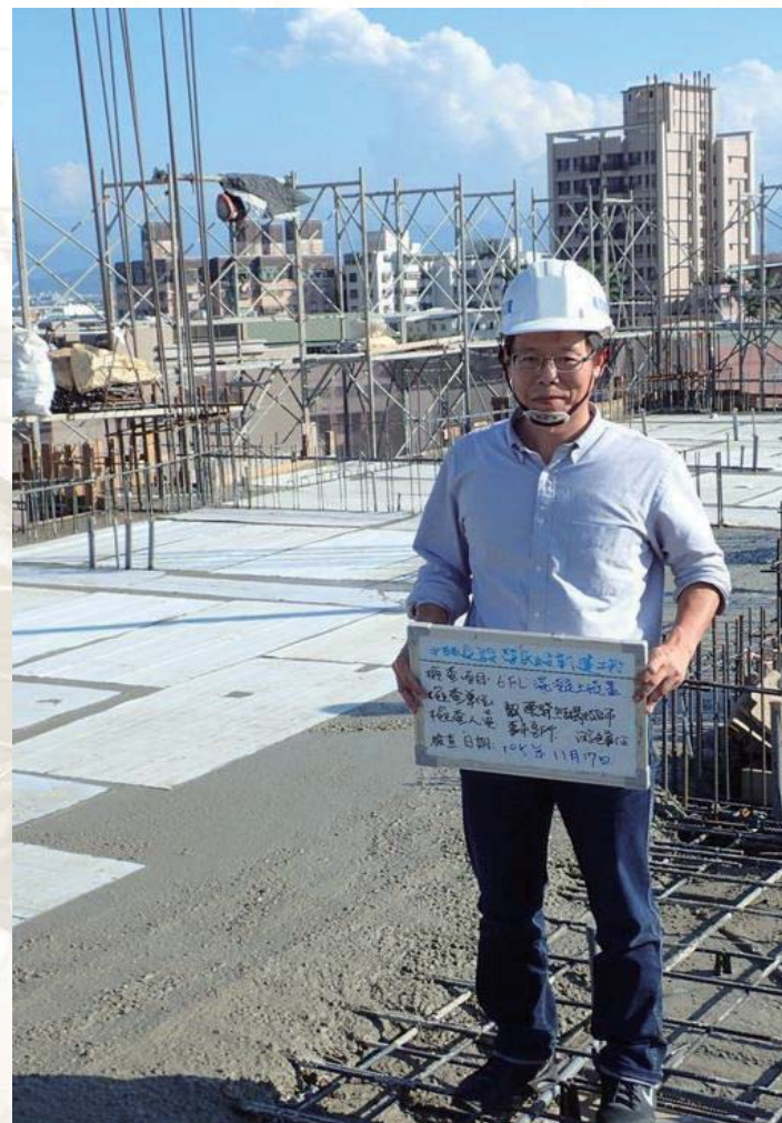
結構安全查驗 – 混凝土工程查驗
