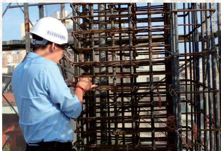
建築安全履歷協會 – 柱鋼筋施工察證
