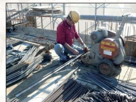
傳統鋼筋裁剪
