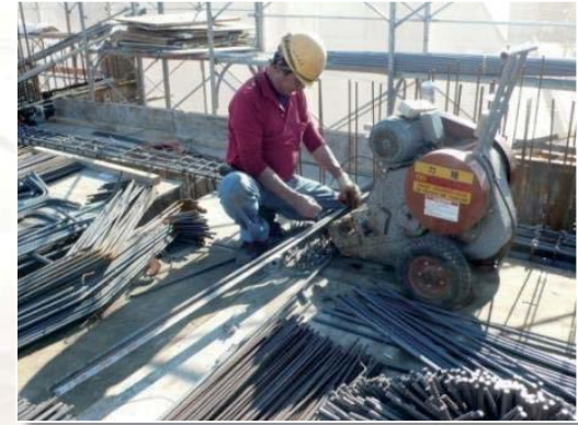
傳統鋼筋裁剪
