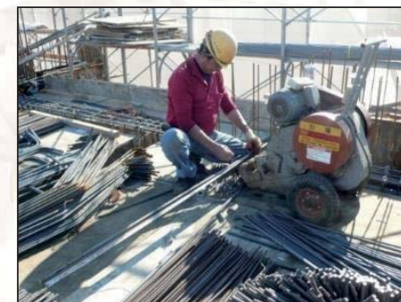
傳統鋼筋裁剪
