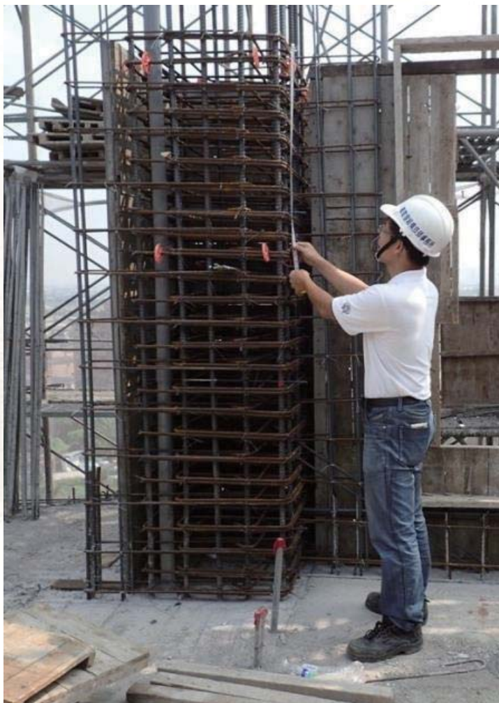
結構安全查驗 – 鋼筋查驗
