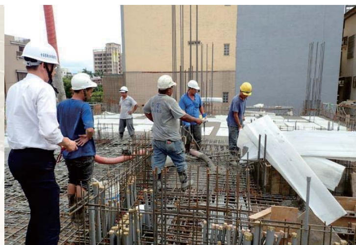
建築安全履歷協會 – 混凝土澆置施工察證
