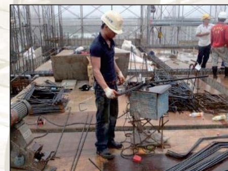
傳統鋼筋彎折
