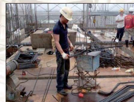
傳統鋼筋彎折
