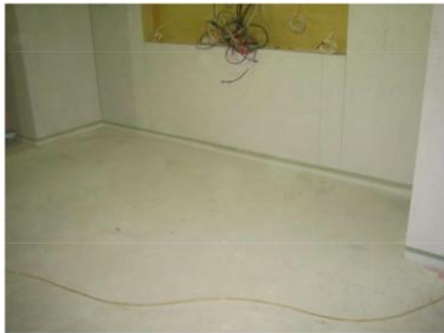
1. 清理施工區域, 固定彈性週邊板
