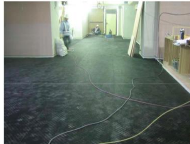
3. 隔振毯滿鋪完成
