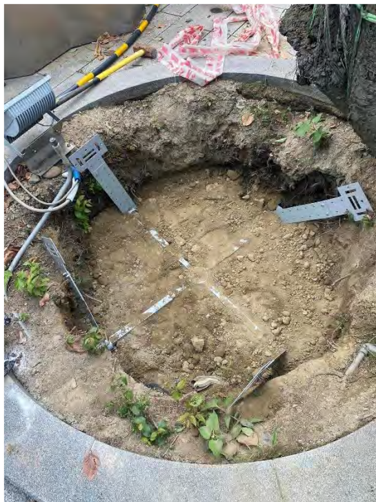
磐地支 架安裝
