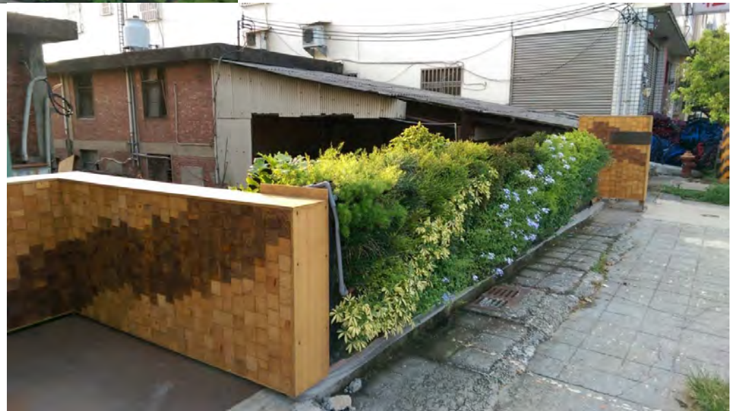
由人行道牆面延伸到地下1樓外牆
