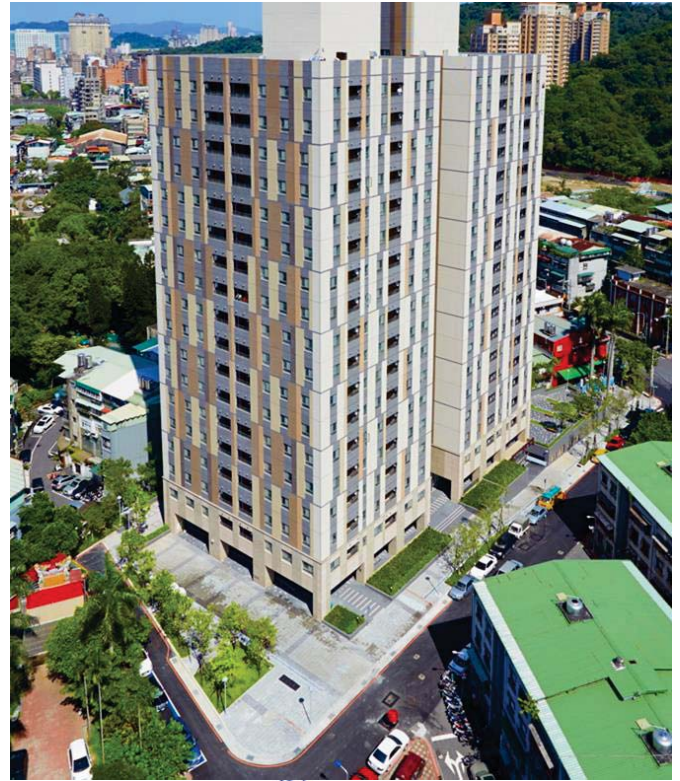
預鑄外牆不吊磚
