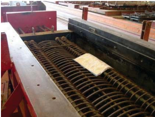
(4) 鋼筋籠定位及調整
