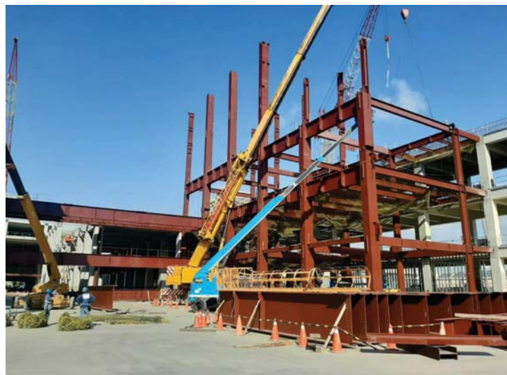
樓版後施作，機電與裝修無法提前施作
