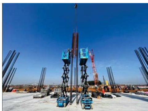
柱鋼筋籠施作
