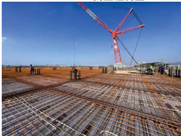
Wire mesh施作
