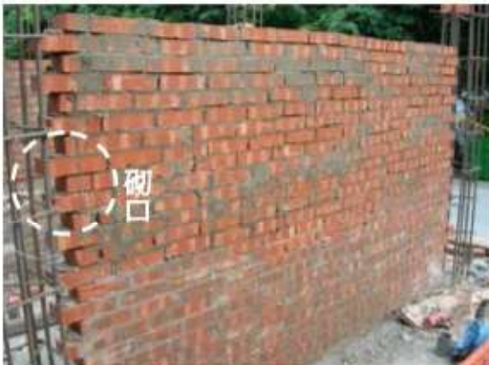
圖 1 先砌式磚牆砌築情形
