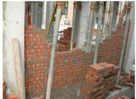
圖 2 後砌式磚牆砌築情形
