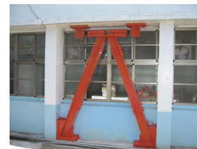
斜撐加裝型式 立面示意圖
