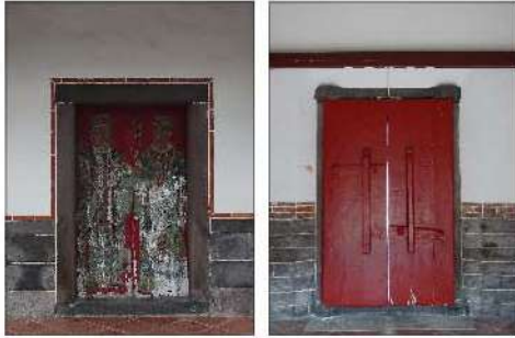
AM1-D1正面現況 AM1-D1背面現況
