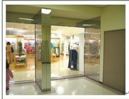
▲ 常時開放式防火門
