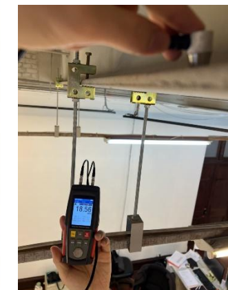
複測鋼樑翼版、腹版厚度 32
