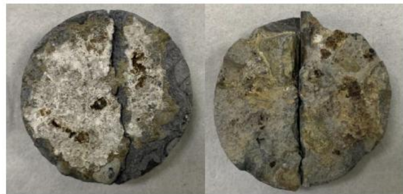
【圖 46】基礎 3 鑽心試體頂面(左)及底面(右)照片
