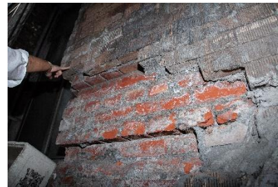
承重磚牆(外牆2.5B、室內牆2B)
