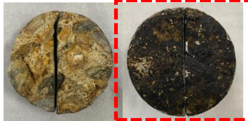
【圖 44】基礎 1 鑽心試體頂面(左)及底面(右)照片
