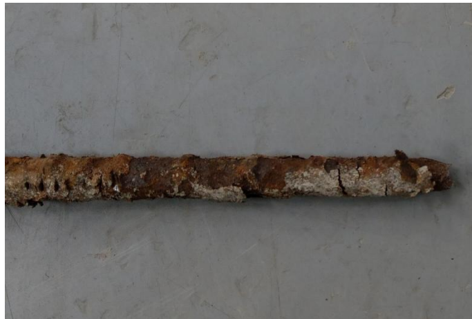
現場取樣原始版筋
