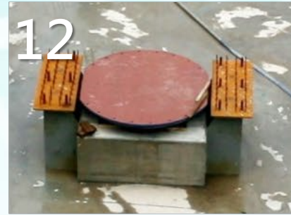
⑫ FPS設置完成
