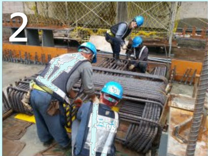
② FPS基礎鋼筋綁紮
