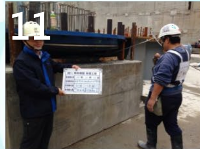
⑪ FPS下方10000psi高強度無收縮砂漿澆置
