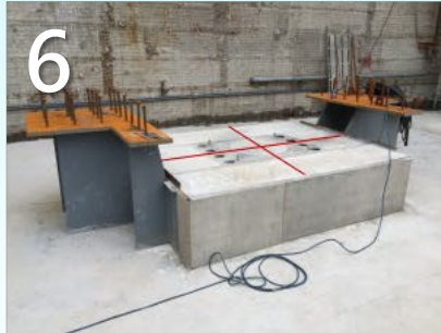
⑥ 基座拆模、清理、安裝基準線放樣
