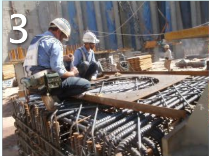
③ 隔震墊底版設置、測量調整、定位
