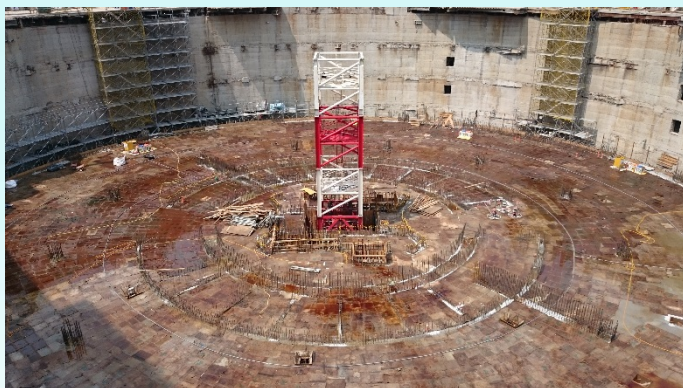
タワークレーン取付開始
