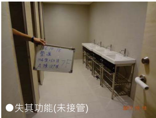
●未依原核定用途使用(堆積雜物)
