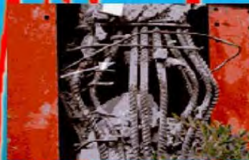
主筋挫屈 柱體壓潰
