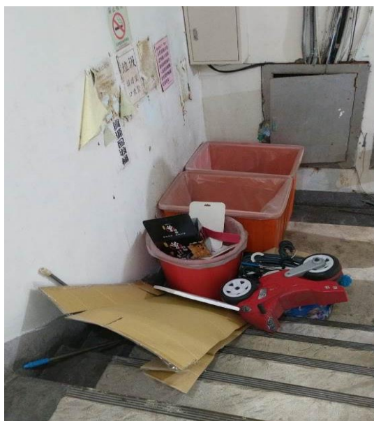
▲ 樓梯間堆積雜物
