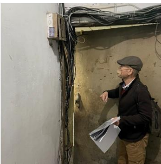
(錦州街住商大樓)
