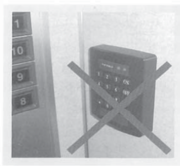
▶ 緊急用昇降設備不可設刷卡機
