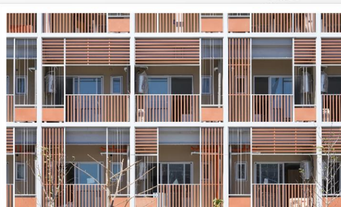
乾式施工及深遮簷設計
