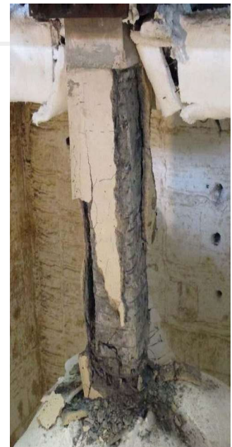
RC柱火害修補後再火害
