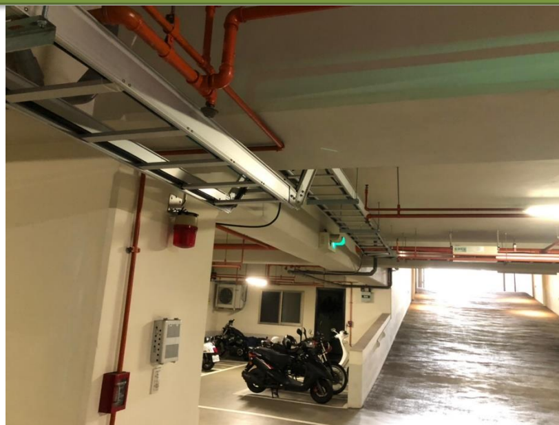
機電系統整合改善 安裝後
