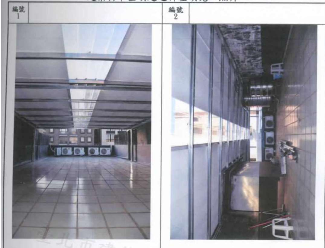
建築物平屋頂建造斜屋頂完工照片
