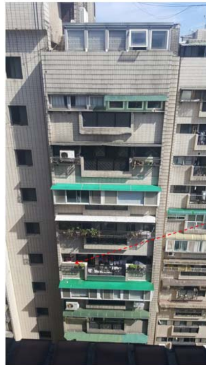
3 號 10 樓外牆磁磚剝落
