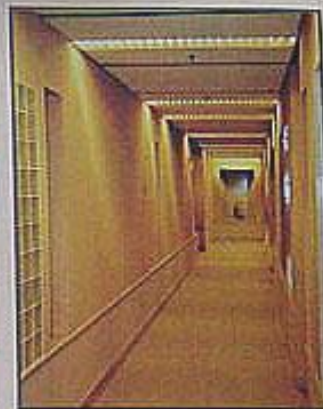
萊特板內牆施工完成
