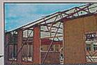
一層樓建築外牆一萊特板施工中
