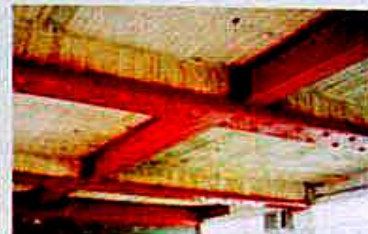
RC梁強度不足時可以鋼板來補強
