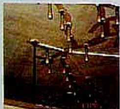
2mm以下之裂縫可以用環氧樹脂高壓灌注來改善
