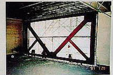
建築師需要良好通風採光時，可以採用鋼樑加斜撐來做補強
