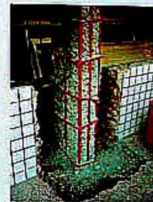
RC柱在補強前以砂之鋼板須先做除銹處理
