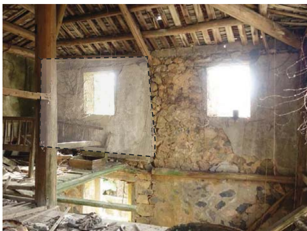
▲ 現況：外牆/內牆
