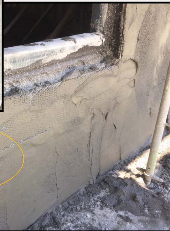
窗戶下方角落貼磚前施打矽利康強化防漏水之能力
