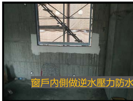
窗戶內側做逆水壓力防水
