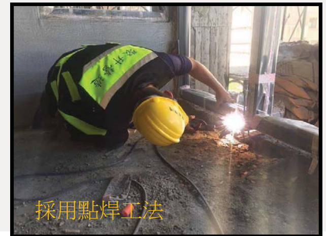
採用點焊工法
