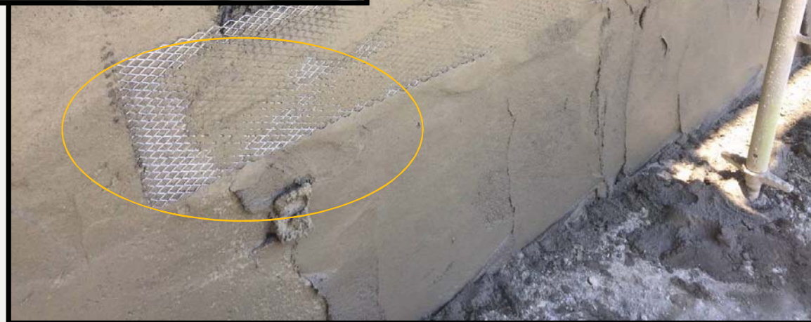
水泥粉刷時加上擴張網協助減少八字腳龜裂所造成的裂縫
