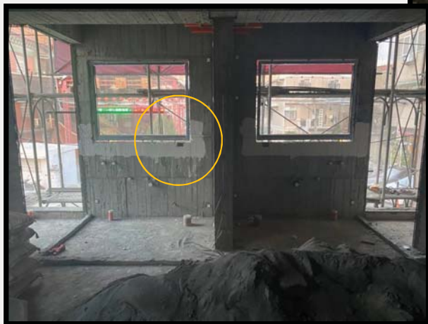
窗戶內部採用逆水壓防水法
