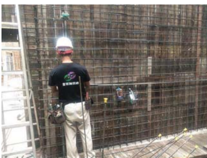
增建樓層結構施工照片
