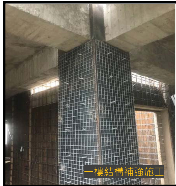
鐵板延伸工程 一樓柱結構補強施工
