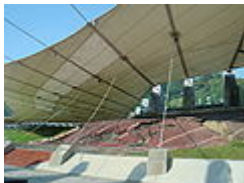
921 地震教育園區 內被震毀的操場，車籠埔斷層切過此處
