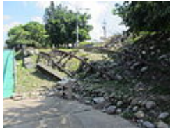
921 大地震後因車籠埔斷層錯動而被破壞的石岡車站月台與軌道
