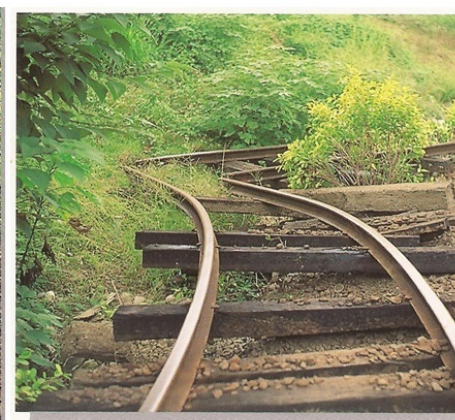
扭曲的鐵軌 集集線鐵路上扭曲的鐵軌。
