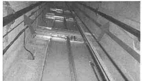
(6)車廂導軌及其固定托架與接軌版（須經重新校正調整確認）。
